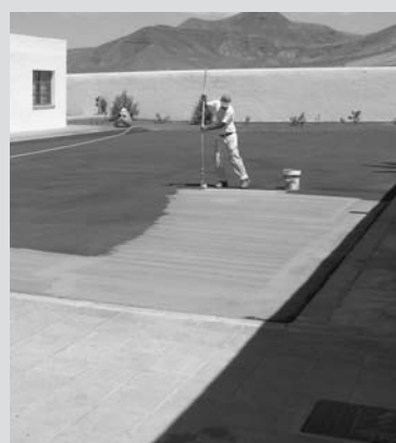
Pista Polideportiva de la Unitaria de Tindaya antes de la intervención
